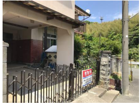
【現況写真】入口周辺
