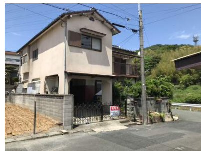
【現況写真】外観
