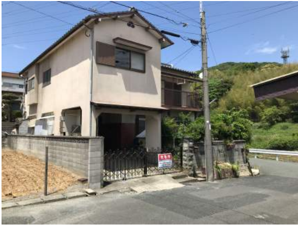
【現況写真】外観
